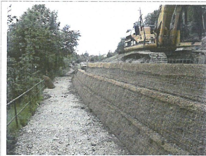
Bild 4 (links): Böschungfrontansicht während der Bauphase
