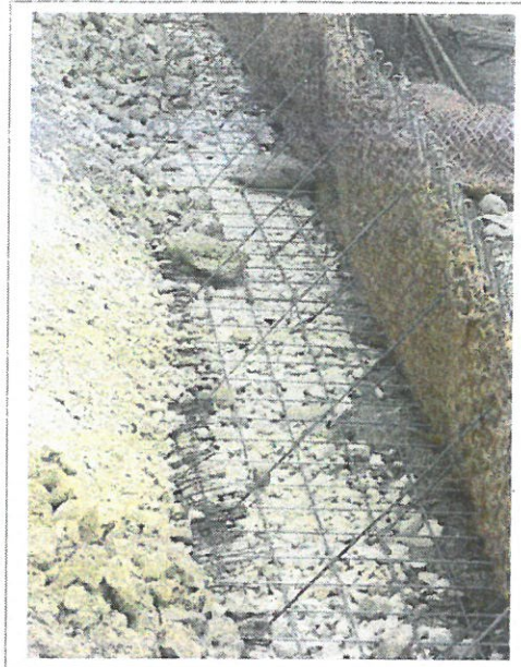
Bild 3 (oben): Stahlgitterelemente und eingelegte Erosionsschutzmatte
